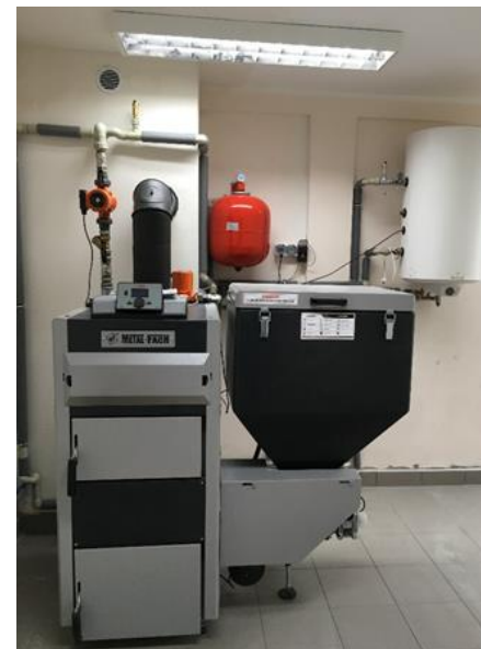
Budowa systemu ogrzewania
