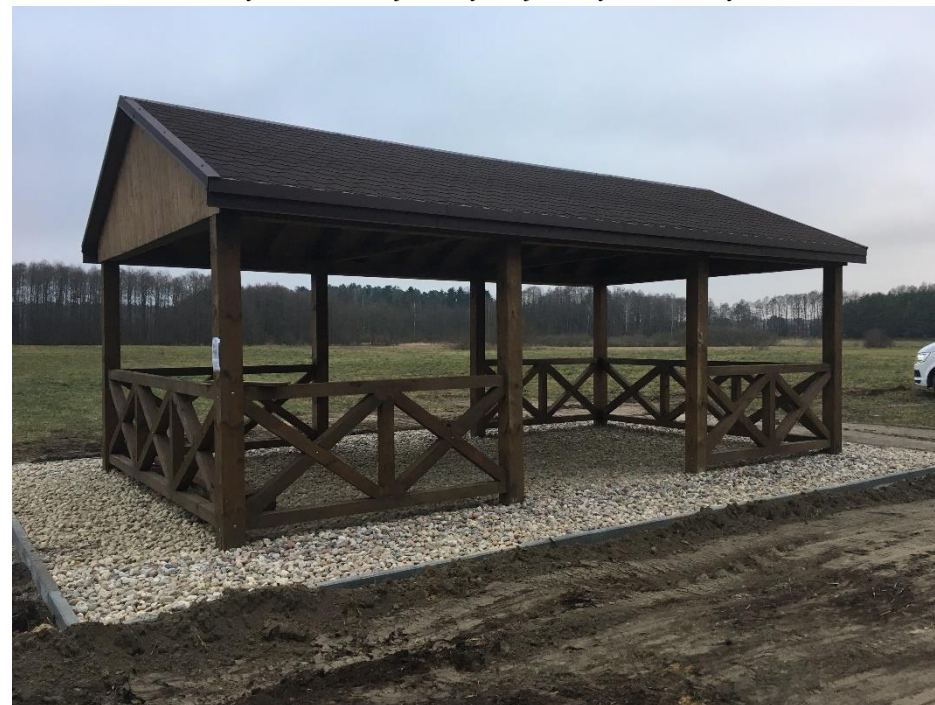
Zagospodarowanie terenu, utwardzenie tłuczniem
