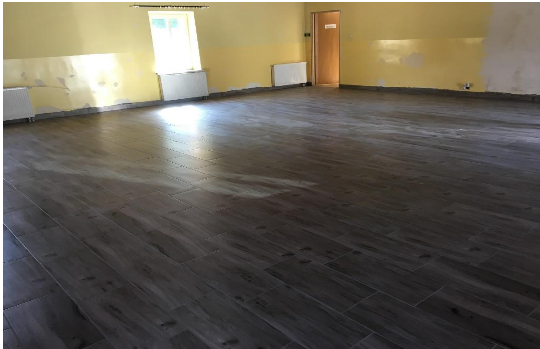
Wymieniona posadzka w świetlicy wiejskiej
