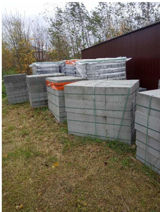
Materiały do wykonania utwardzenia terenu za budynkiem świetlicy wiejskiej w Naguszewie
