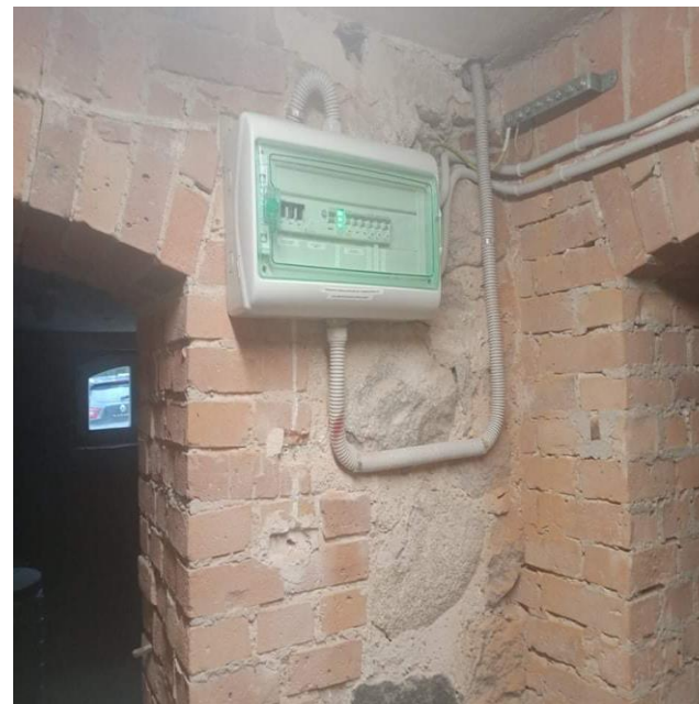
Remont pomieszczeń piwnicznych w SP w Rumianie
