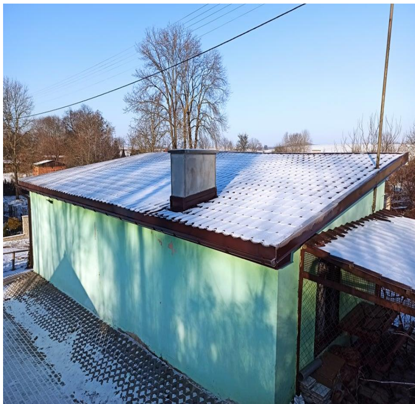
Wymieniony dach w świetlicy wiejskiej w Nowej Wsi
