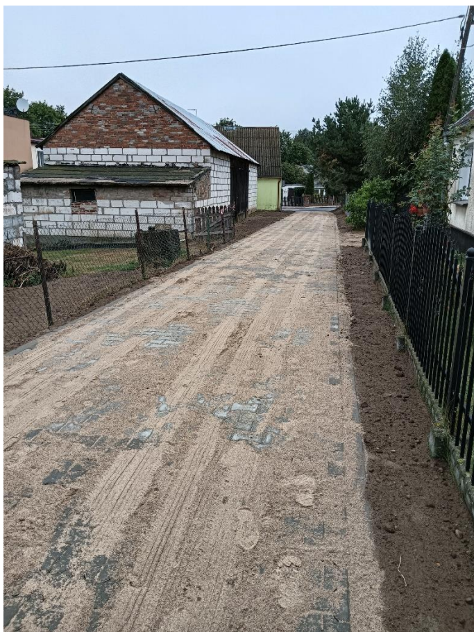
Wykonanie odcinka drogi z kostki brukowej oraz chodnika przy placu zabaw
